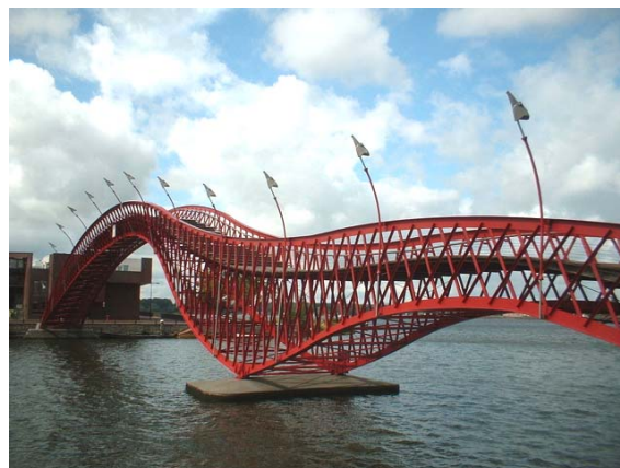
Kładka w dzielnicy portowej, Amsterdam
